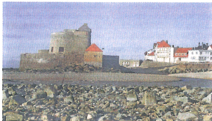
Le chantier de rénovation du fort Vauban démarrera en octobre, dès l'obtention des autorisations, après la saison estivale d'ouverture au public.
